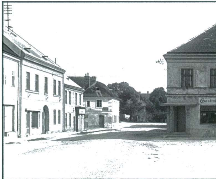
Das Haus von Fleischhauer Johann Wittmann (erstes Haus von links), in dessen ersten Stock sich später die Kanzlei des Rechtsanwaltes Dr. Josef Lamm befand, 1928. In diesem Haus befindet sich heute die Erste Bank. (Sammlung Herbert Unger)
